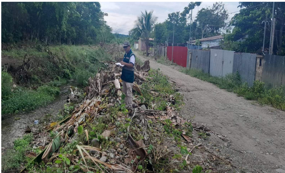
FIGURA N° 02: SE APRECIA SOCAVACIÓN Y DERRUMBE DE CERCO PERIMETRICO DE VIVIENDA MARGEN DERECHA DE LA QUEBRADA PUEBLO UNIDO
